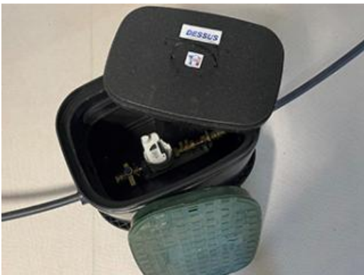
Regard de compteur équipé d'une plaque isolante ©RESE
